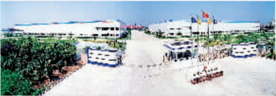
占地面积200多亩的人民电器上海高科技工业园
