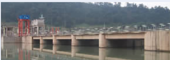
能源业/人民电器集团四川雅安水利枢纽
