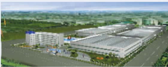
正在建设中的人民电器中原(湖北)生产基地
