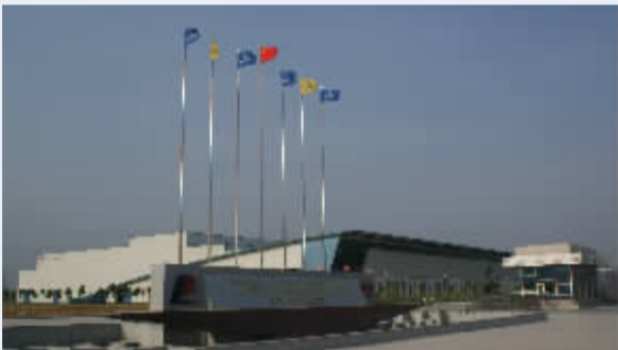
人民电器江西(抚州)变电设备生产基地
